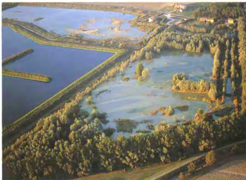
Foto 28 - Oasi di Torrile.
